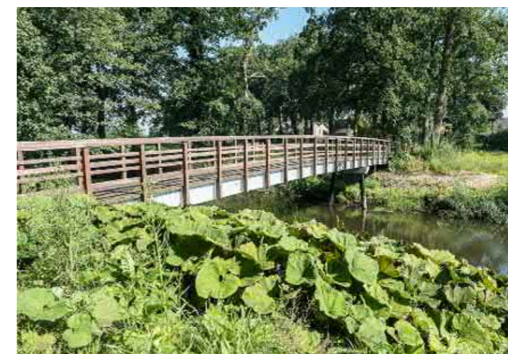
BRUGGEN OVER DE GROTE WETERING
