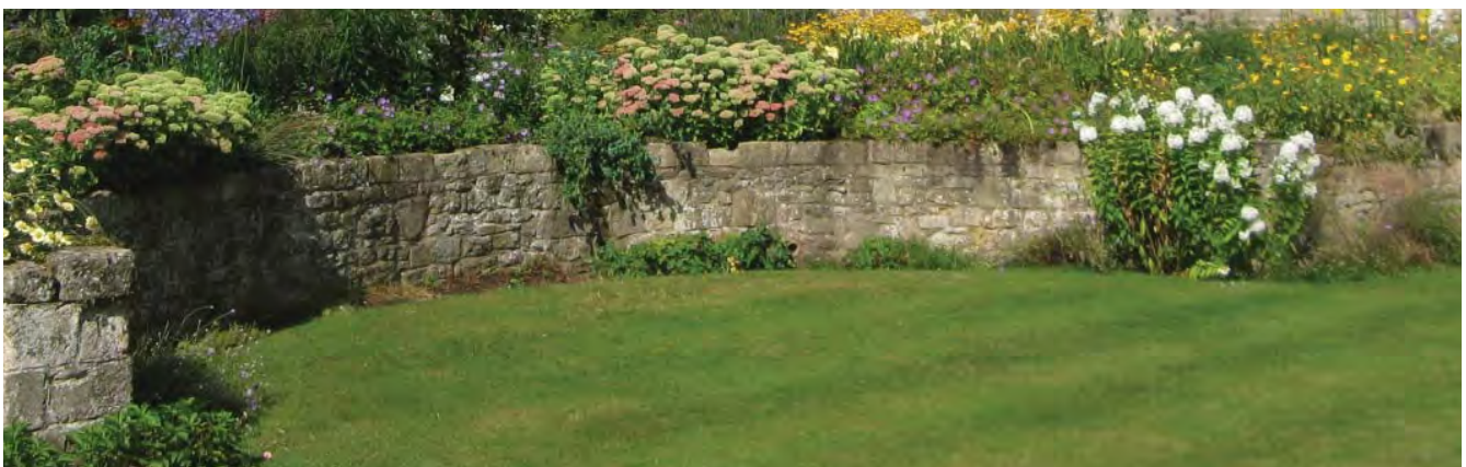
Hoogteverschillen opgevangen in keerwand
