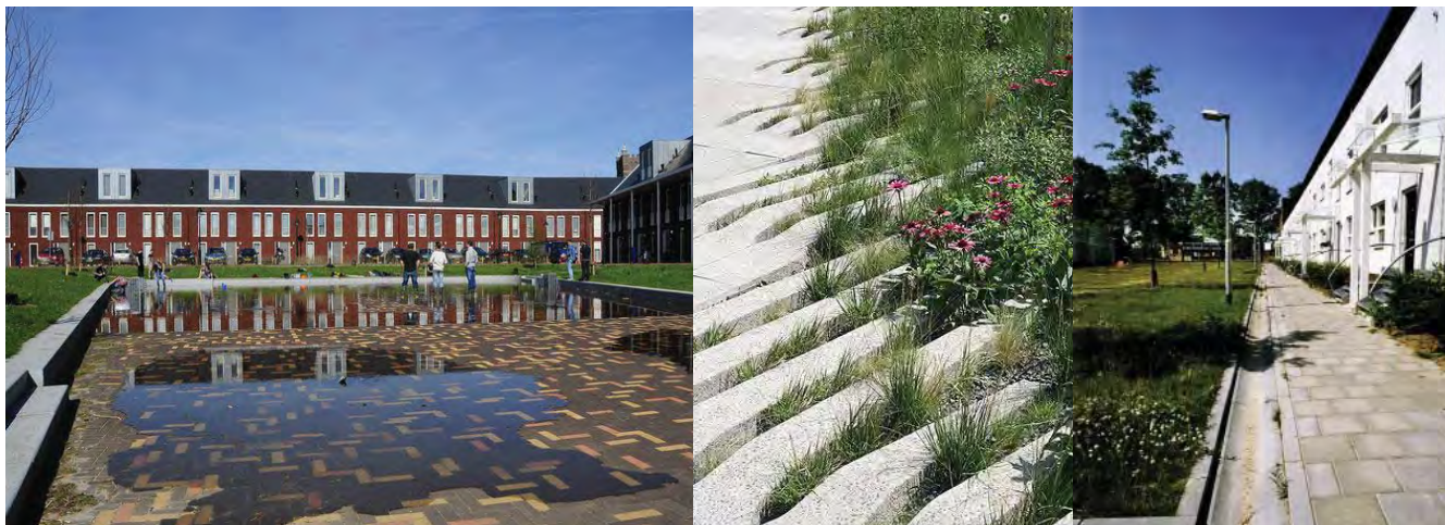
Voorbeeld van waterberging (Eikendonkplein 's-Hertogenbosch), waterdoorlatende verharding en afkoppelen
